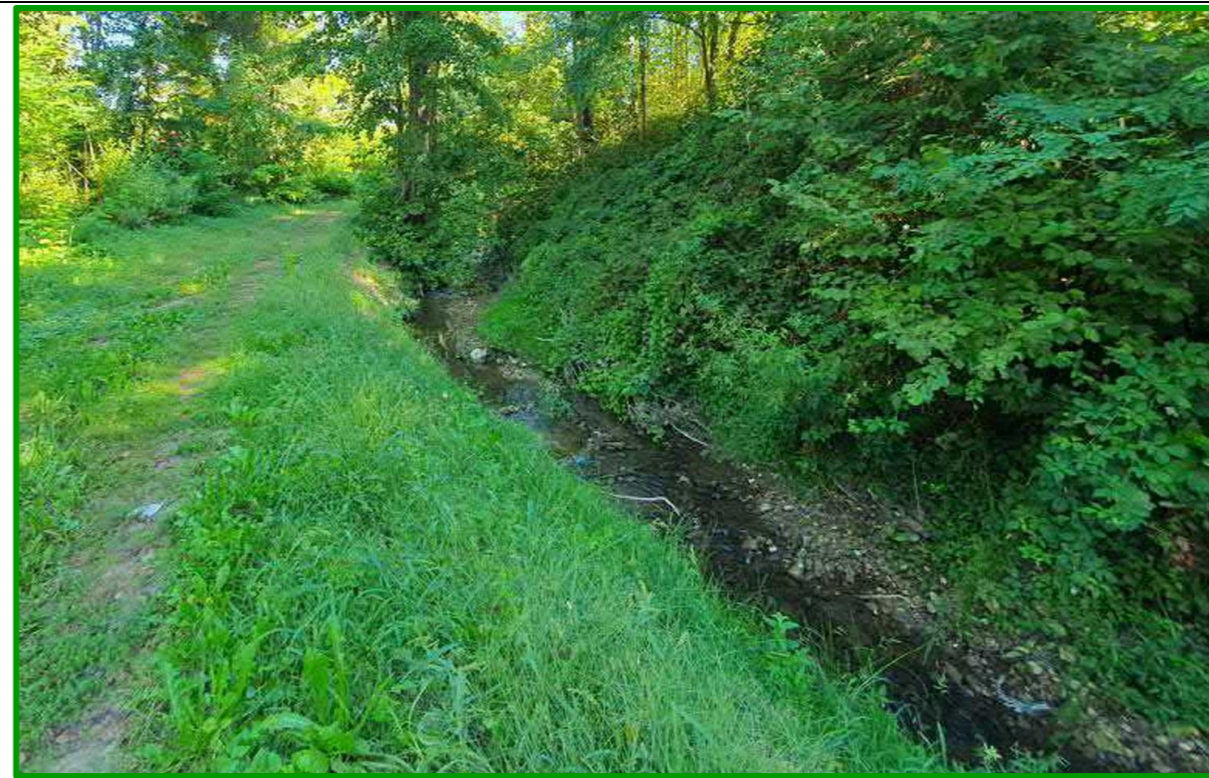
Slika 12. Potok Čučerska reka - stacionaža oko od km 0 + 280,00 – do km 0 + 300,00 – put uz desnu obalu potoka (Izvor: Tau projekt d.o.o.)
