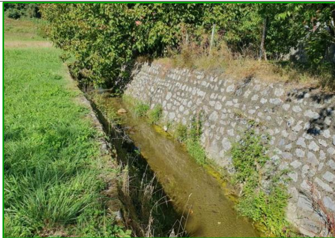
Slika 21. Potok Čučerska Reka – stacionaža km 0 + 510,00 – postojeća obloga korita (Izvor: Tau projekt d.o.o.)
